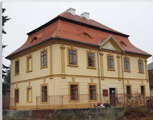
Vikariát českolipský: Jitřava, fara - obnova fasády
