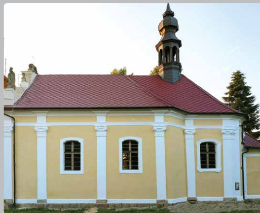
Vikariát lounský: Široké Třebčice, kostel Povýšení sv. Kříže - obnova střechy a fasády
