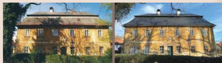
Bělá pod Bezdězem - farní budova, obnova střechy
