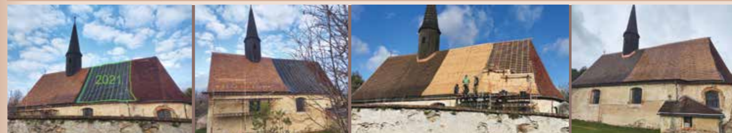
Dolní Oldříš - kostel sv. Martina, obnova střechy
