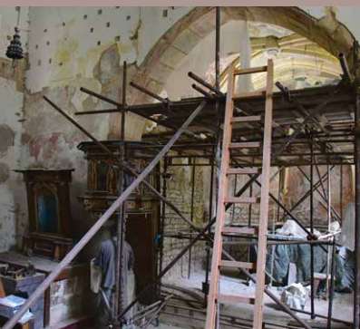
Minice (kostel sv. Martina) restaurování interiéru
