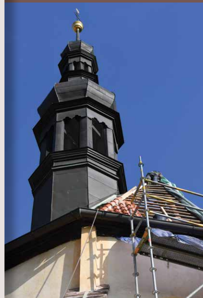
Kadaň (kostel Čtrnácti sv. Pomocníků) obnova střechy klášterního kostela
