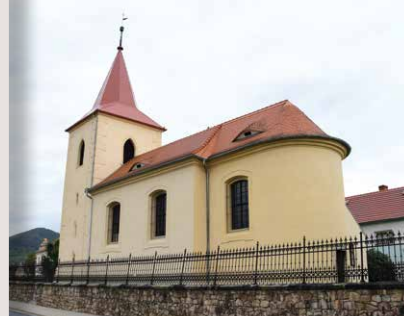
Mlékojedy (kostel sv. Martina) po kompletní rekonstrukci
