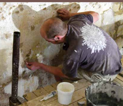
Minice (kostel sv. Martina) restaurování interiéru
